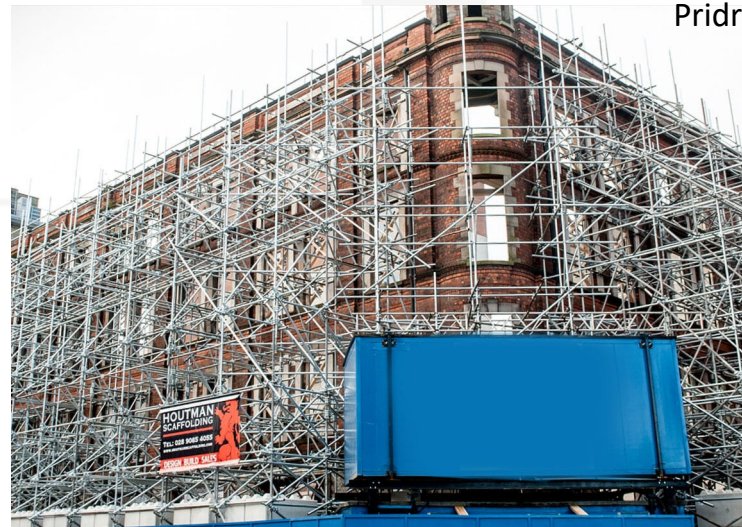
Pidržanje cijevnim skelama
